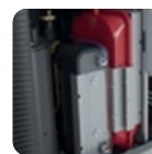
Expansievat
